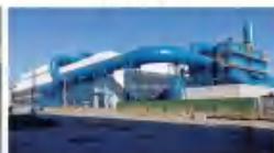
电炉除尘系统设备(电炉冶炼区)
